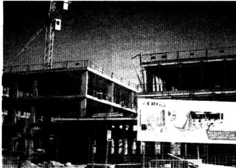
Imagen de la construcción del nuevo instituto en Paterna
