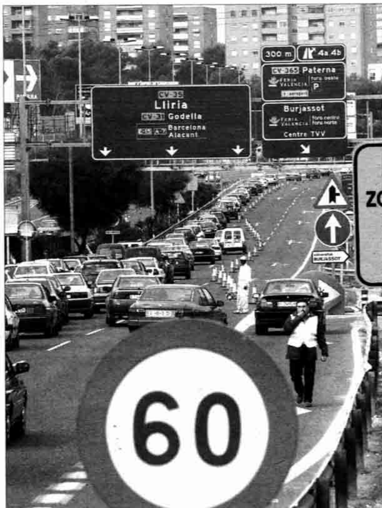
Imagen de unas obras en la autovía de Llíria a la altura de Paterna. /JESÚS SIGNES
