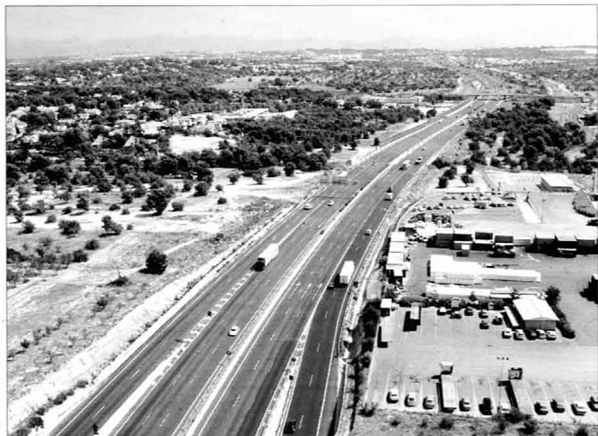
El actual by-pass, a su paso entre La Cañada, y el polígono Fuente del Jarro de Paterna. /MRW-FOTOGRAFÍA AÉREA
