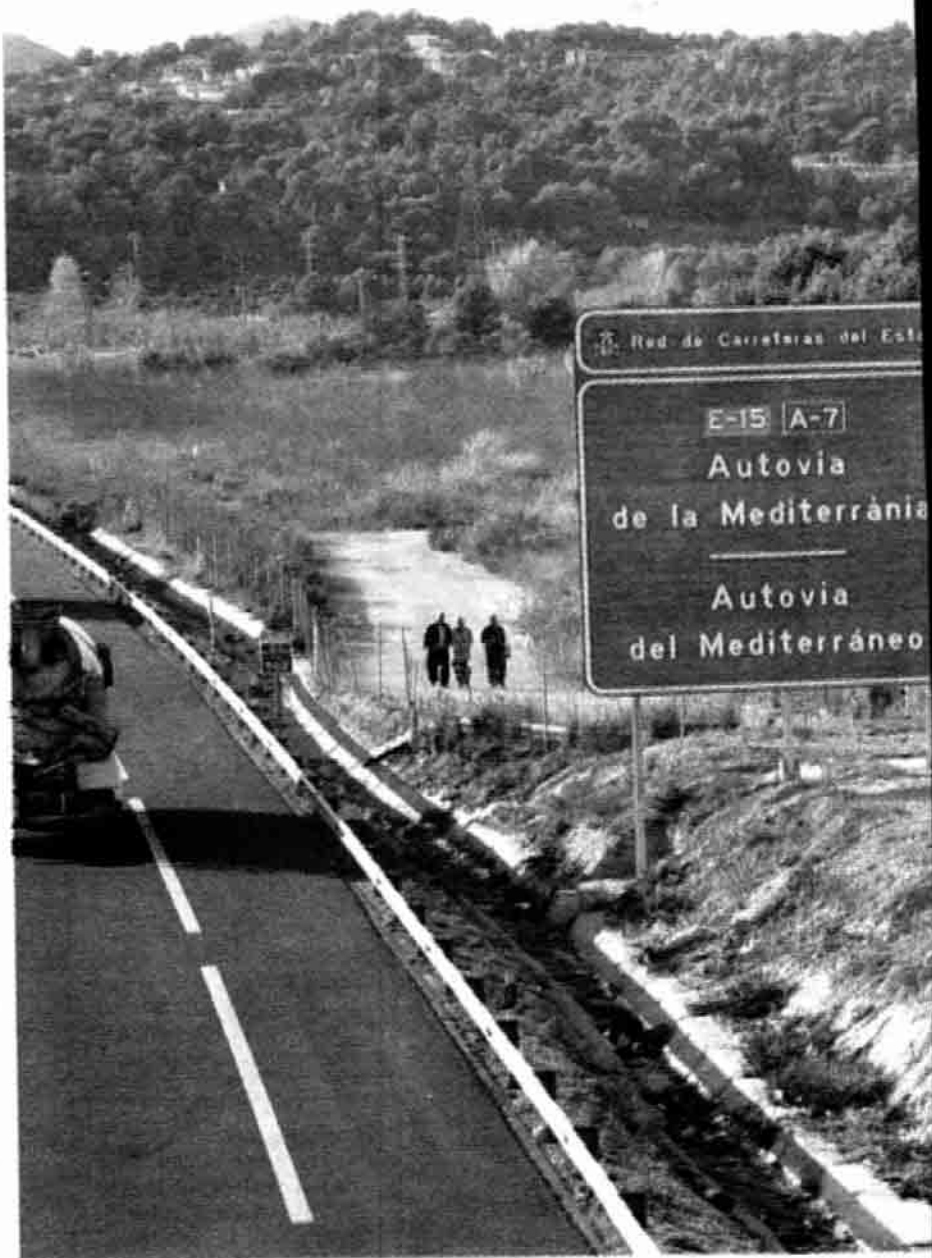
Una parte de pinada, próxima al río, podría ser arrasada
